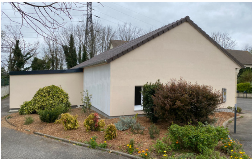
Vue de l'arrière du bâtiment
