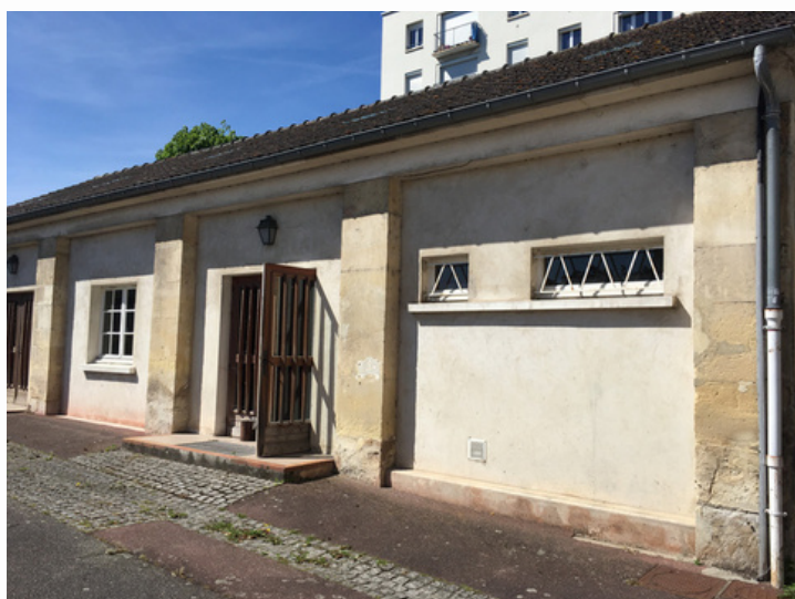
Vue extérieure du bâtiment
